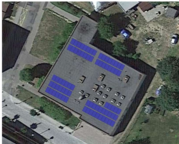
Obr. č. 78 – Objekt Vodní 636
