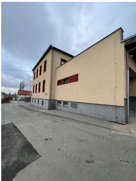
Obr. č. 33 – Budova Kulturního domu
