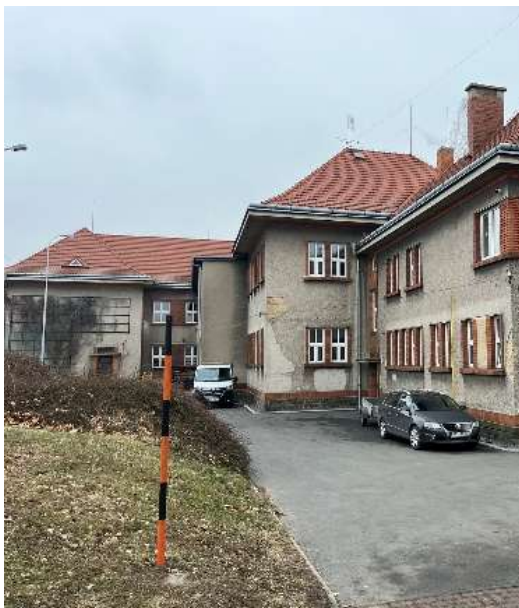
Obr. č. 20 – Budova nižšího stupně ZŠ
