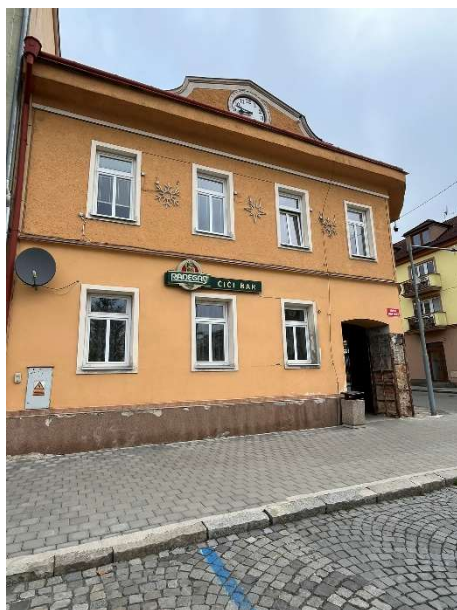
Obr. č. 31 – Budova Správy bytového fondu města Vítkov
